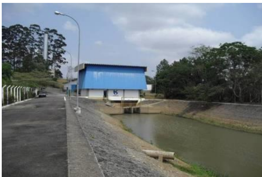
Foto 01 – Captação no Rio Paraíba do Sul e Casa de Bombas
