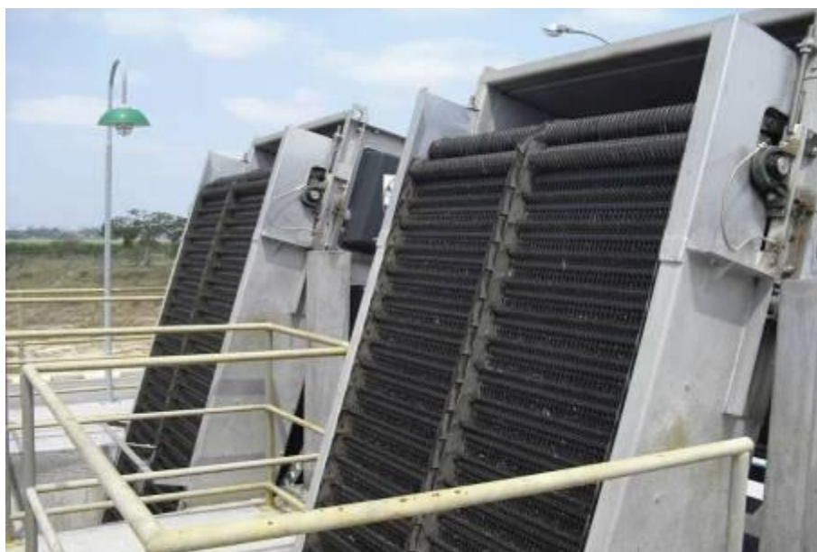
Foto 15 – Gradeamento Mecanizado para Retirada do Material Grossoiro
