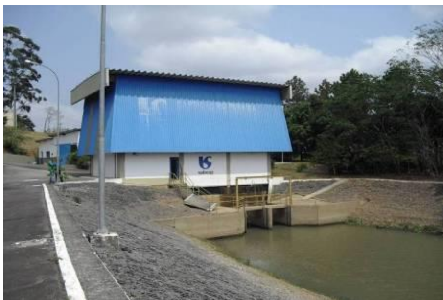
Foto 05 – Estação Elevatória de Água Bruta do Rio Paraíba do Sul
