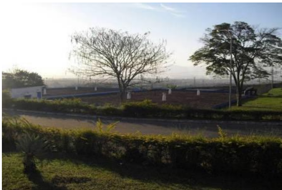
Foto 10 – Vista do Reservatório R1 (R1.1 e R1.2), localizados na área da ETA II
