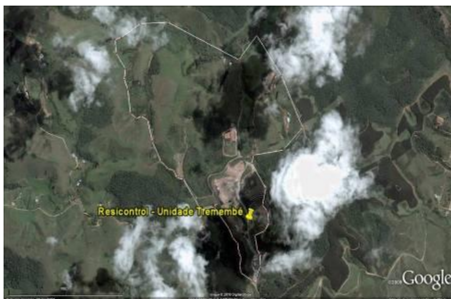
Foto 26 – Limite da gleba ocupada pelo empreendimento (Fonte: Google)
