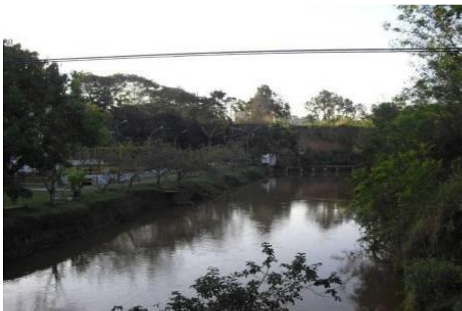
Foto 03 – Barragem de Nível da Captação do Rio Una
