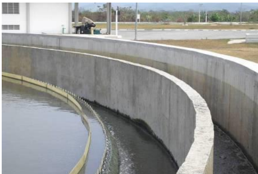
Foto 20 – Canaleta de Coleta do Efluente do Decantador
