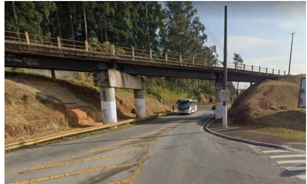
Figura 79. Túnel Ver. Vicente Fonseca Lima – mão dupla e passagem exclusiva de pedestre
