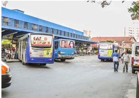
Figura 111. Rodoviária Velha – Configuração das plataformas exige manobra dos ônibus em conflito com outros veículos e com intensa circulação de pedestres
