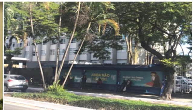
Figura 125. Ponto na Av. Tiradentes, 377, em frente ao Hospital Regional
