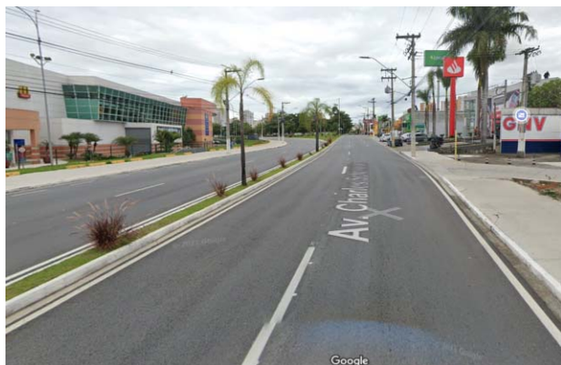
Figura 100. Av. Charles Schneider – 2 faixas com canteiro central
