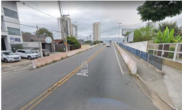
Figura 78. Viaduto Edvaldo Cabral de Vasconcelos – mão dupla e passagem exclusiva de pedestre
